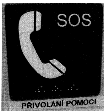
Obr. 3 Příklad provedení piktogramu nouzového volání na bezbariérovém WC
